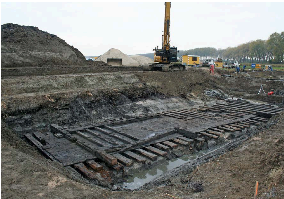
Afbeelding 11 De fundering van een oude sluis in het project wallen van Sluis. (Bron: Provincie Zeeland 2016).
